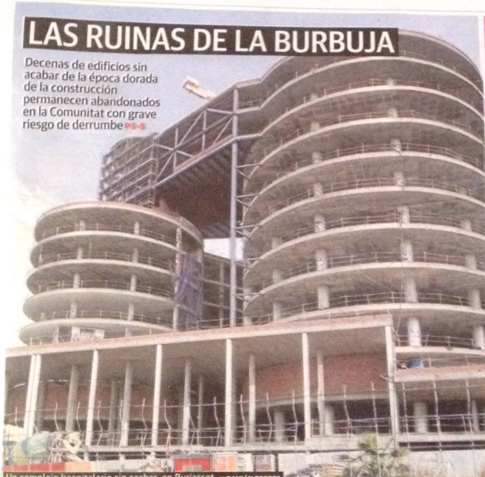
Un complejo hospitalario sin acabar, en Burjassot. :: DAMIÁN TORRES
